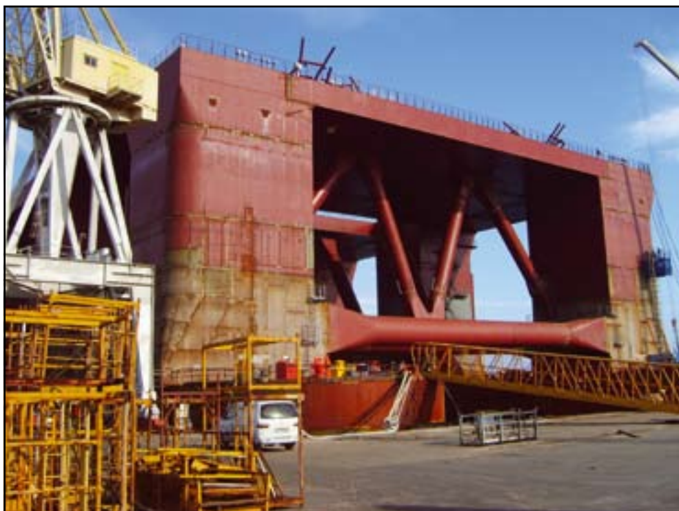
Открытая палуба корпуса Scarabeo 8 на заводе Fincantieri в Палермо
