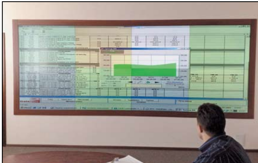
Рис. 2. Центральный диспетчерский щит. Демонстрация системы
