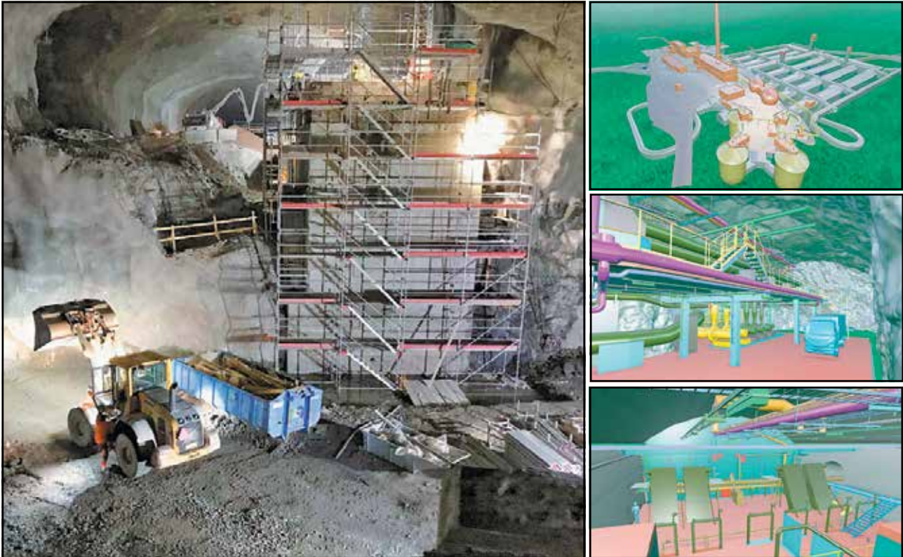
Проектирование и строительство подземной станции очистных сооружений в городе Эспоо
